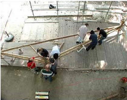
Montage im Workshop
