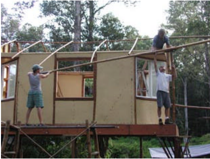
Dachkonstruktion vor Ort
