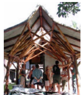
Blickfang: das Dachtragwerk
