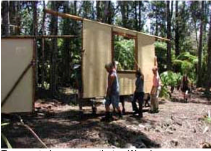
Transport einer vormontierten Wand
