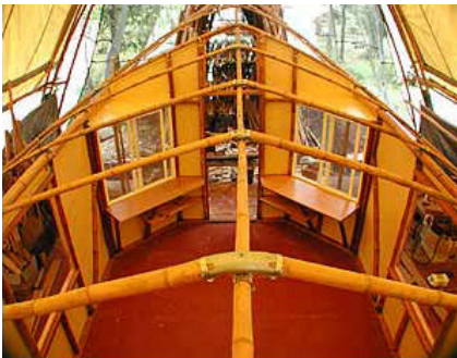
Klammerverbindung der Dachkonstruktion
